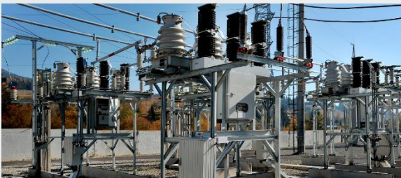
Montagem de Subestações
