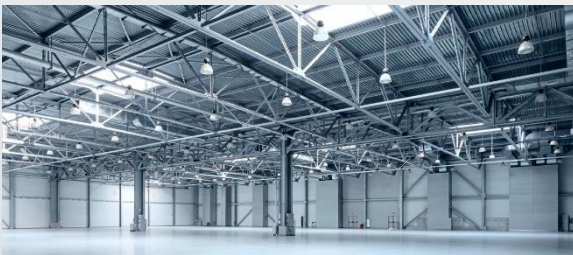
Iluminação Industrial e Comercial, Aterramento e SPDA
